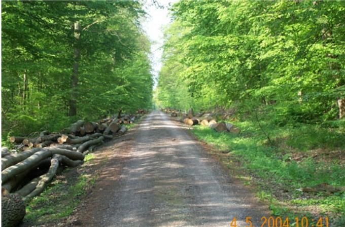
Überwachsenes und Herausgefahrenes Deckschichtmaterial kann durch Auffräsen der Bankette und anschließenden Profilieren dem Weg wieder zugeführt werden.
